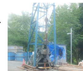
▼井戸の掘削の様子
