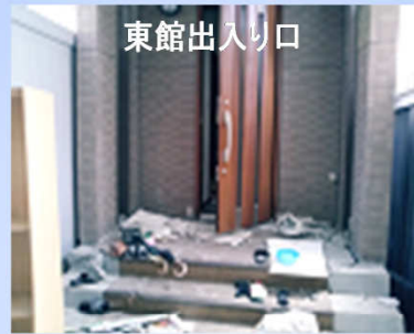
本館と東館を繋ぐ勝手口です。階段のコンクリートが割れ、ずれて段差が出来ており、ドアが閉まりませんでした。
