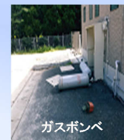
ガスボンベが倒れ、ガス漏れを起こしていました。
